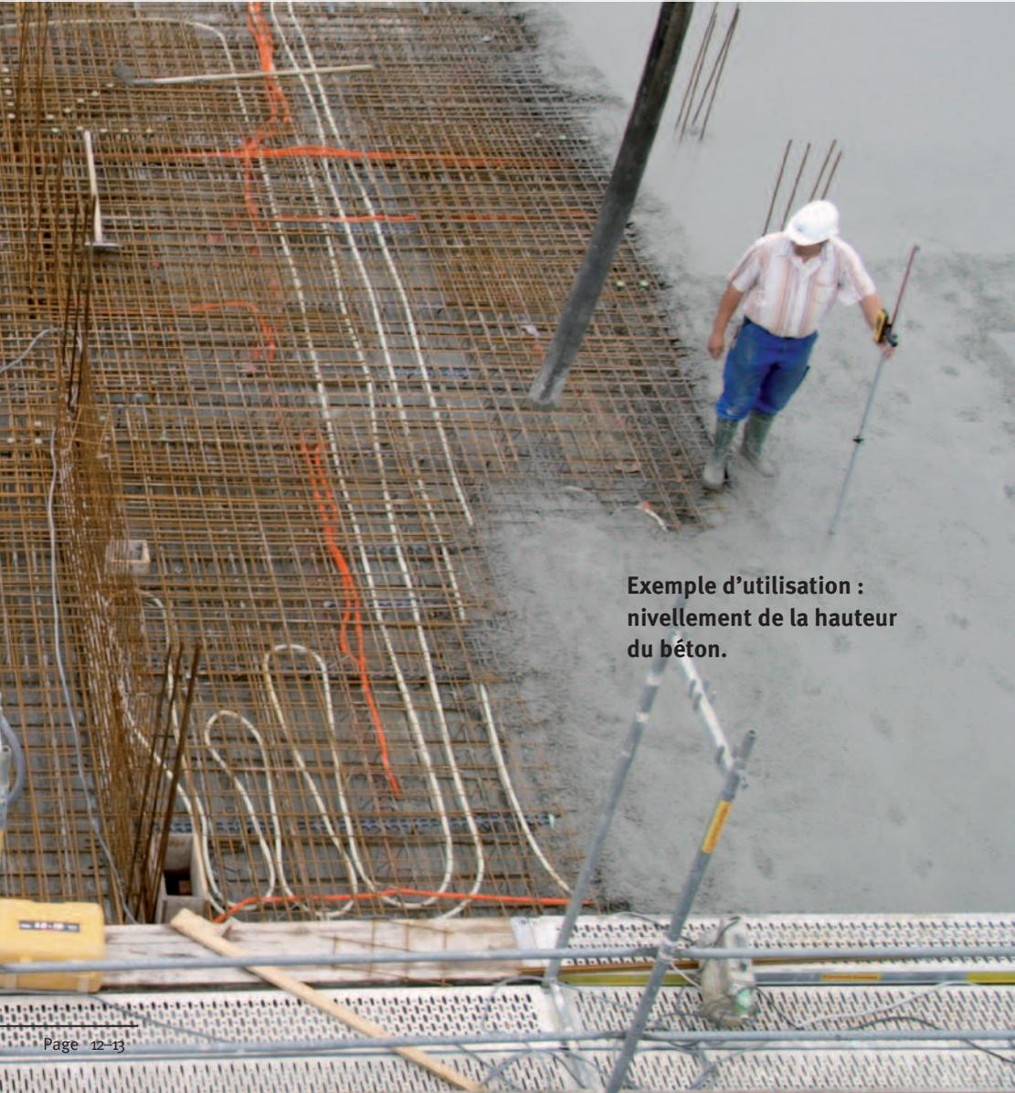
**Exemple d'utilisation : nivellement de la hauteur du béton.**
